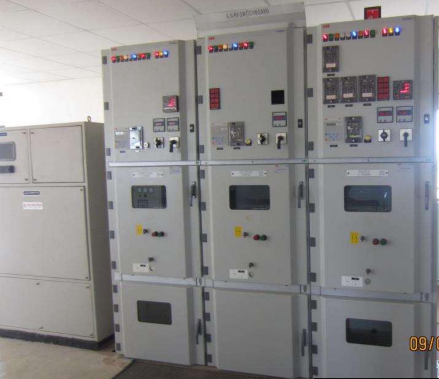
6.6 KV HT VCB, ABB Unigear ZS
